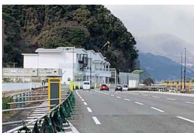
①道の駅「たのうらら」
