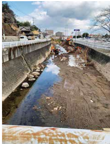
⑦祓川浚渫
